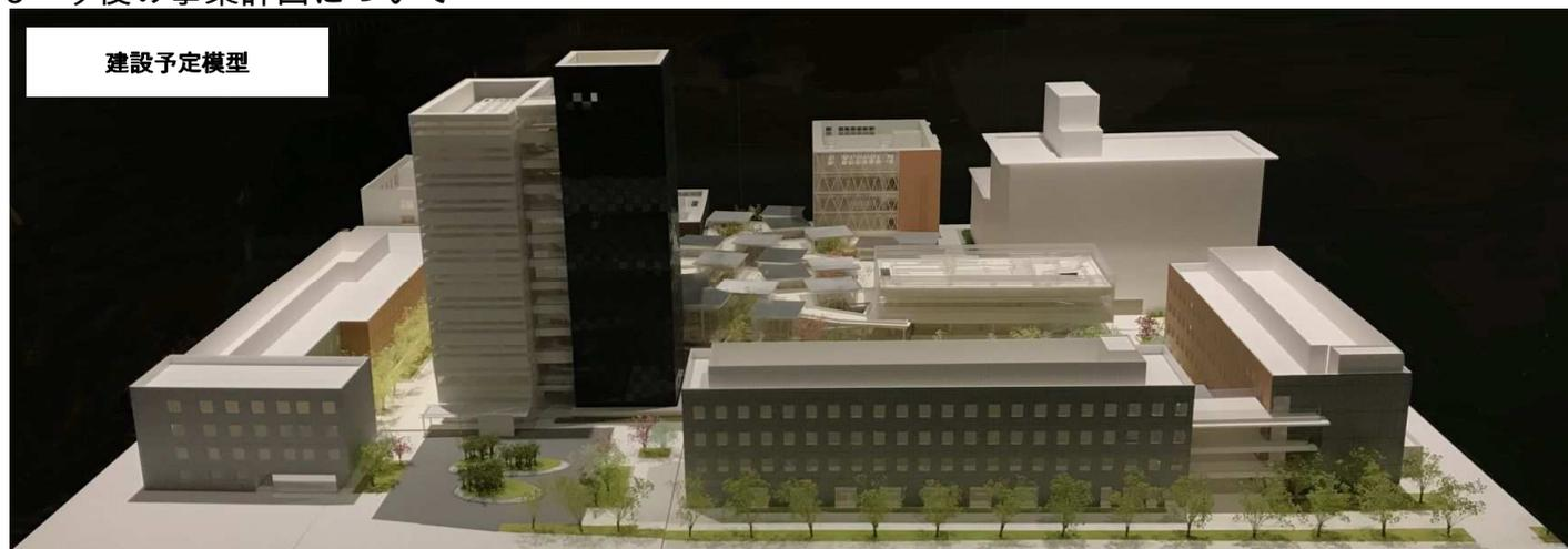
東大阪キャンパス整備工事は第二期工事として平成30年度完成予定の講義室・教員ゼミ室・教員室からなる西棟(※)(延床面積6,460.87㎡)の建設が始まります。それに続いて実験室・研究室・実習室を中心とした北棟(※)(延床面積944.05㎡)・南棟(※)(延床面積3,778.70㎡)、約500席を確保できる食堂を備えた東棟(※)(延床面積4,136.52㎡)の新築工事が始まります。※建物名称は仮称です。
