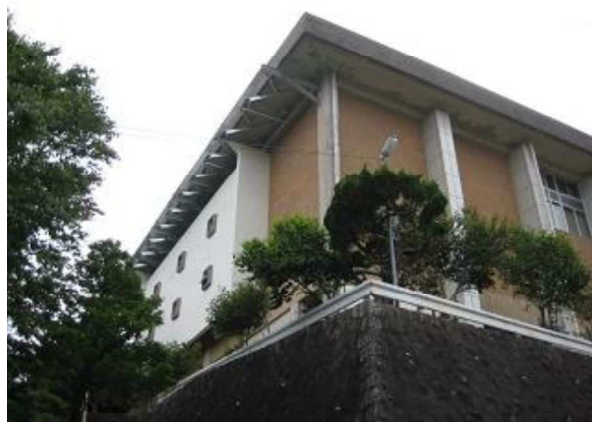
新宮高等学校・中学校 体育館
